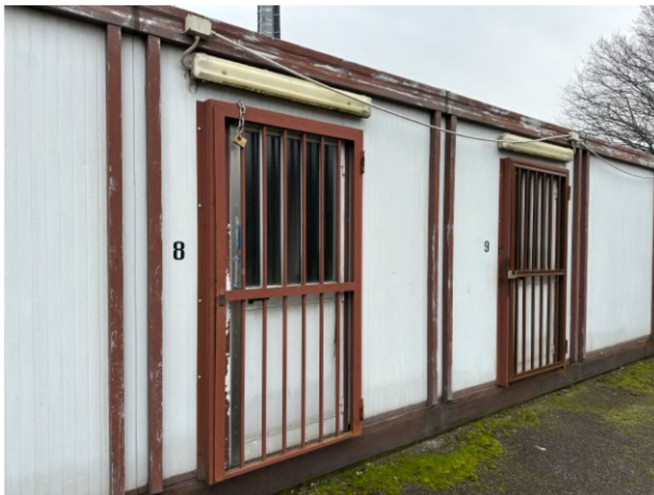
Figura 3-8 – Spogliatoi/servizi in prefabbricati
